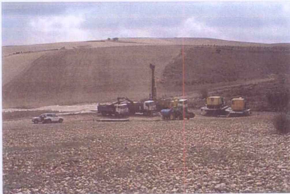
Foto 1. – Emplazamiento del área de las perforaciones.
